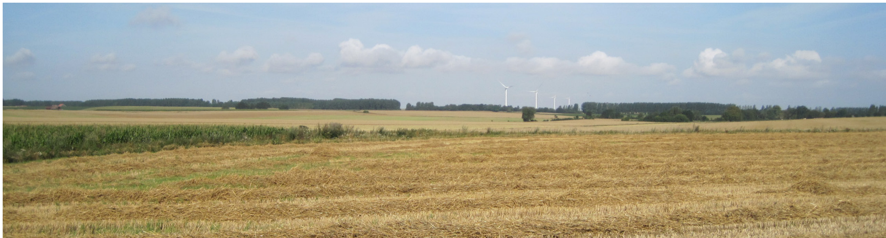
Le parc éolien du Canton du Quesnoy - Commune de Beaudignies -
